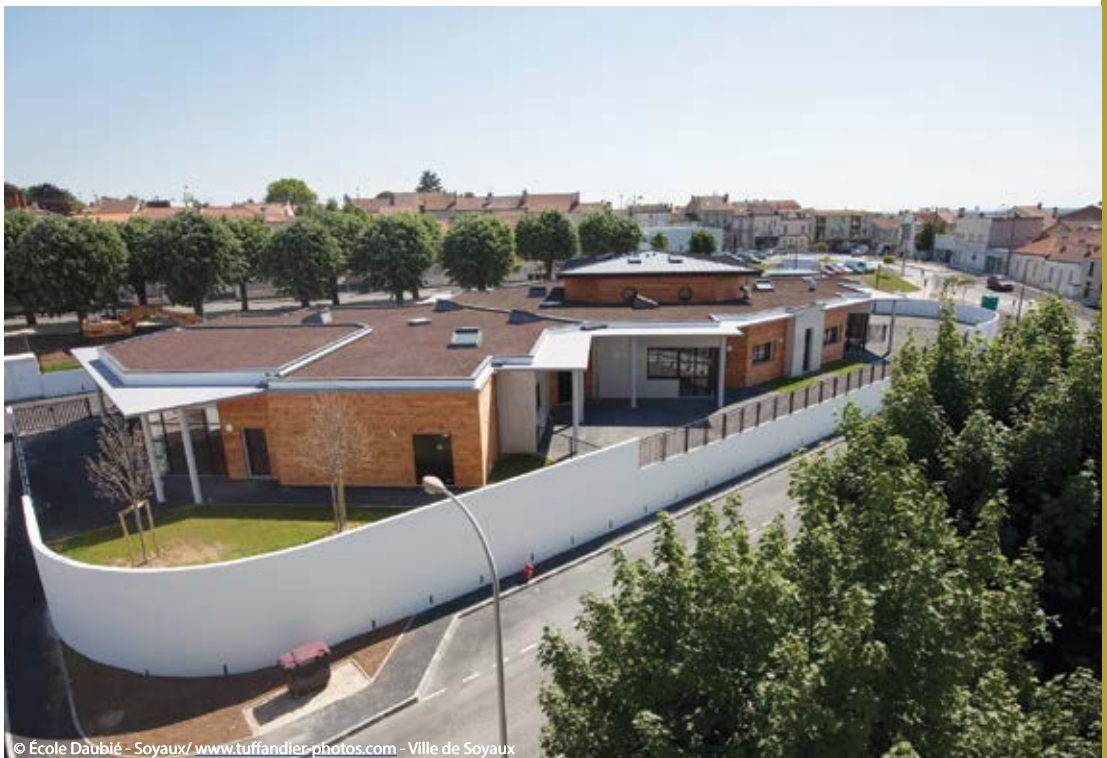
© École Daubié - Soyaux / www.tuffandier-photos.com - Ville de Soyaux
